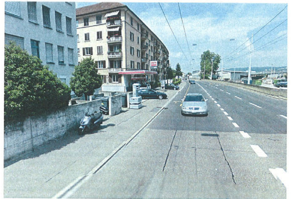
Millionenumsätze: «Blechpolizist» an der Zürcher Hohlstrasse.
